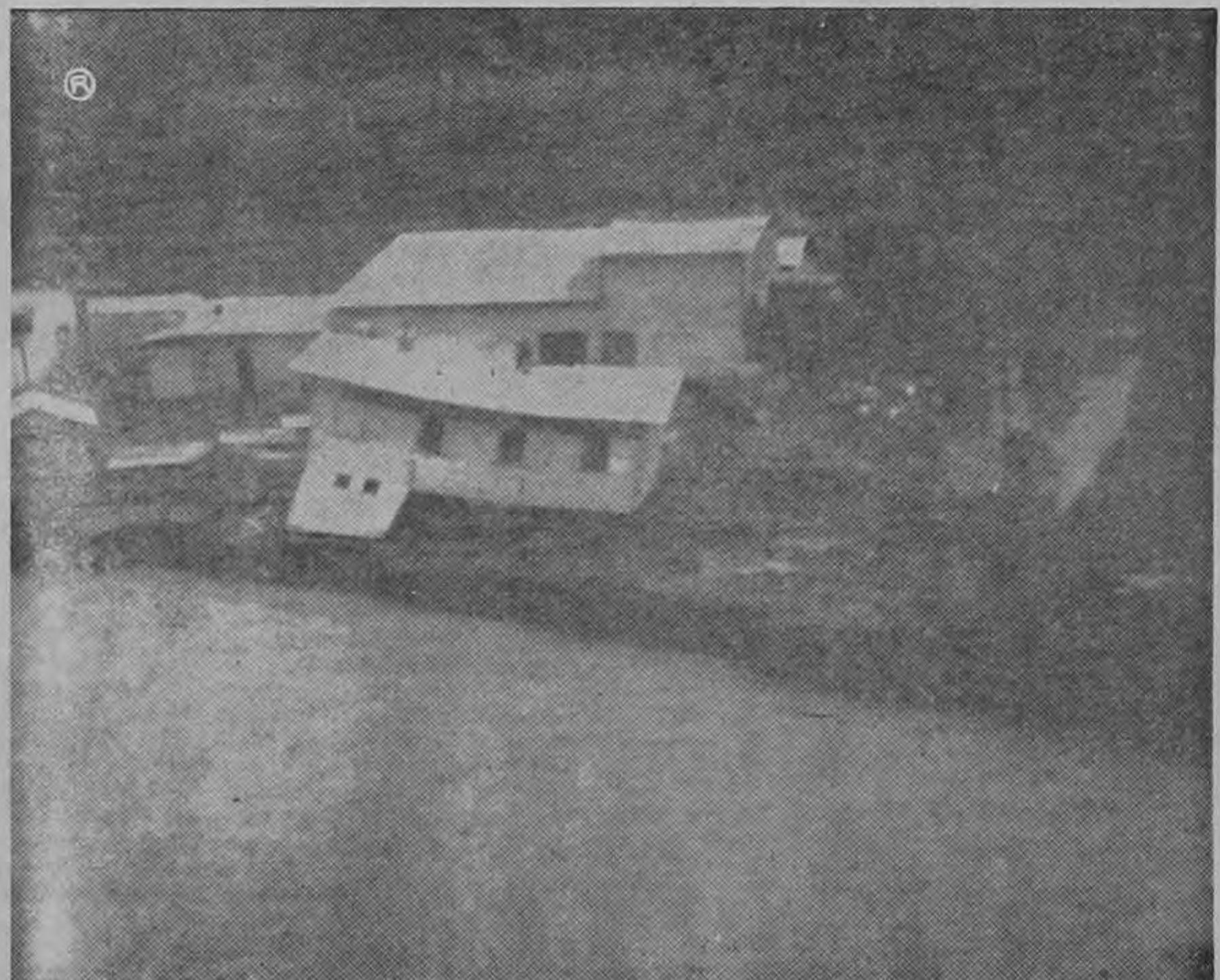
HACIENDA BAHIA DESTROZADA. La fotografía, captada desde el aire por el Dr. Fernando Cruz, muestra los daños enormes que causó el "pequeño" río Uvita en las instalaciones de su finca. Claramente
